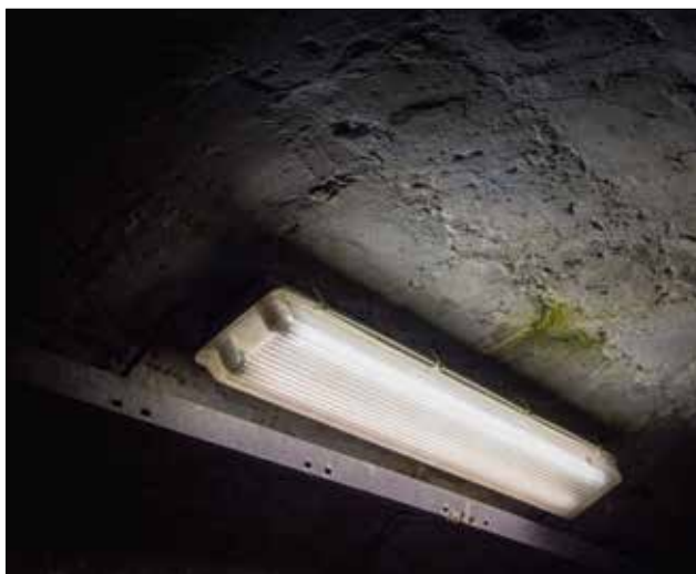
Lysstofrør har været en yderst populær lyskilde gennem en årrække, og derfor har der allerede nu været mange udskiftninger - og flere er på vej.
