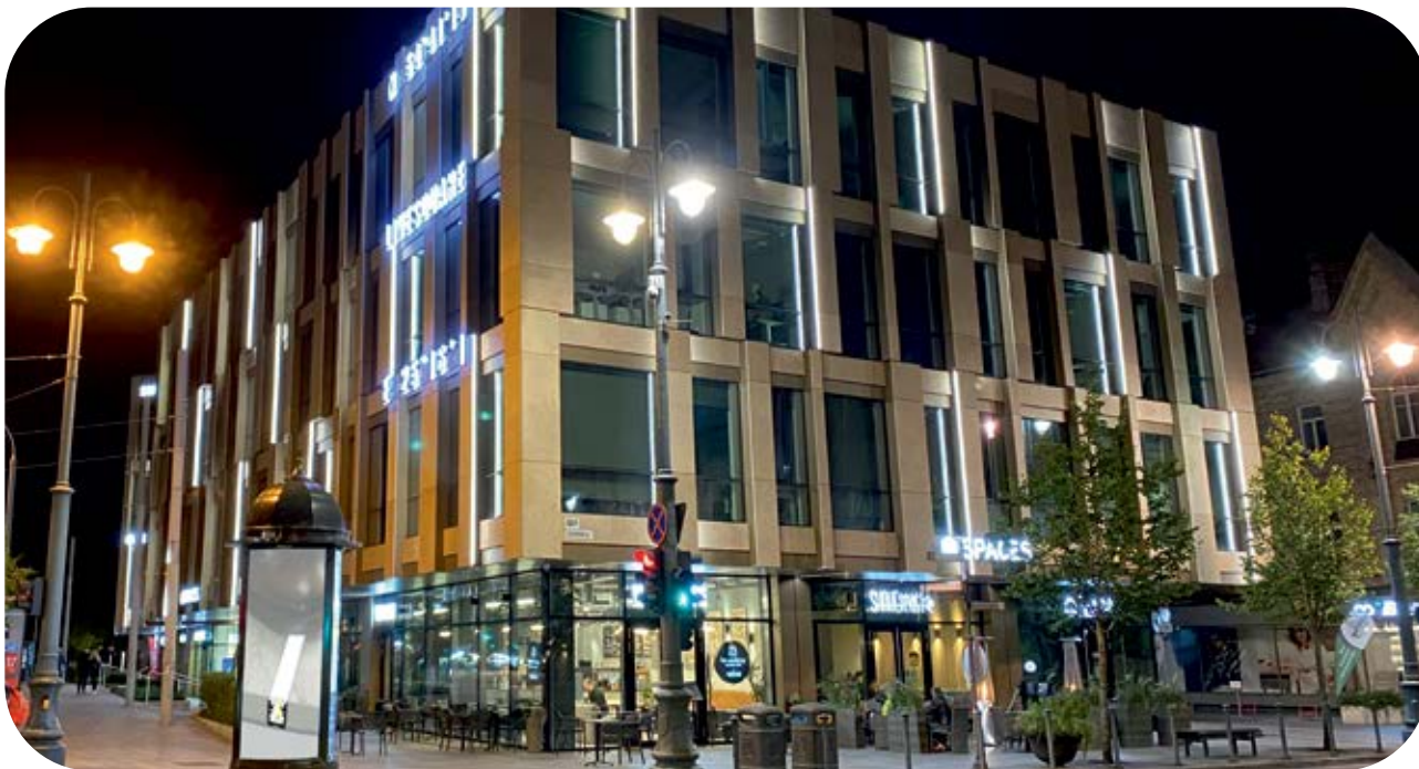
↑ Facadebelysning med Alu profil FLOOR12 (s. 73). Mulighederne er utallige!
