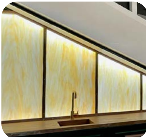
↓ LED bånd bag glasvæg - DIOFLEX® PRO COB 15W (827318, s. 5)
