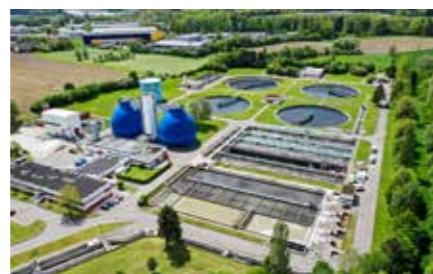
Langwiese rensningsanlægget har fire rensestadier, hvilket betyder, at selv sporstoffer og mikroforurenende stoffer kan fjernes
