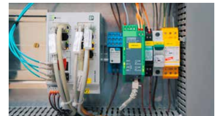
Managed switch FL SWITCH 2312-2GC-2SFP kan tilpasses fleksibelt til den respektive netværksinfrastruktur via to SFP-porte og de to combo-porte
