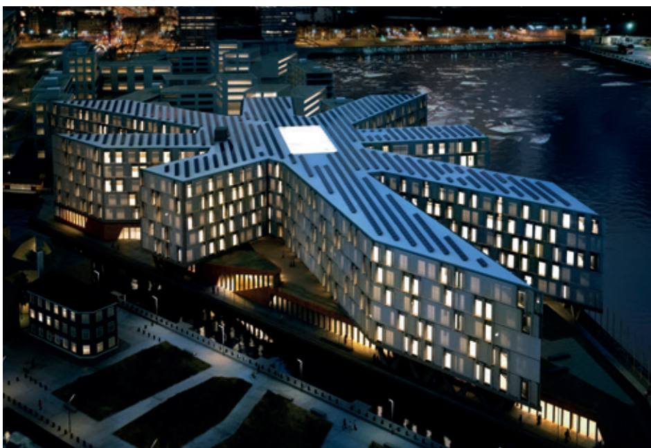
FN Byen, København, hvor belysningen er udført med WINSTA®-installationsstikforbindelser
